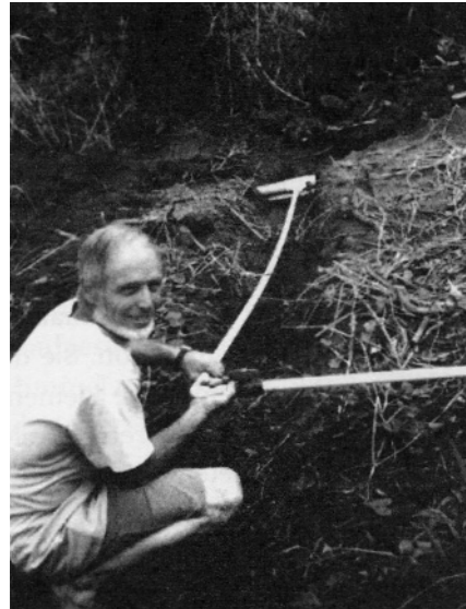
David Hosick legt waterleiding aan voor alle schoolgebouwen.
